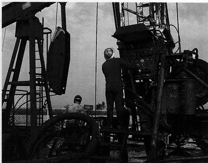
Pompage de pétrole...
